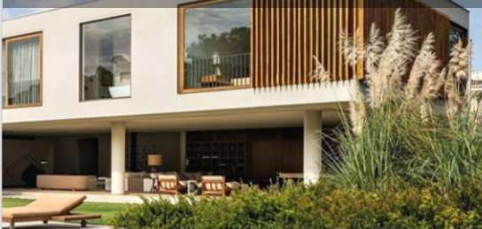
Casa YB – Studio Arthur Casas
