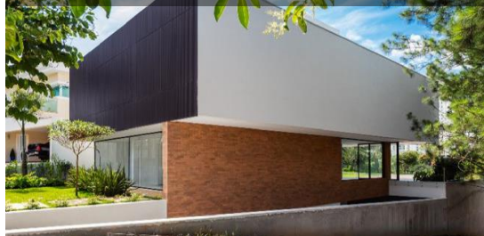
Casa Granada 2 - Rodrigo Latorre
